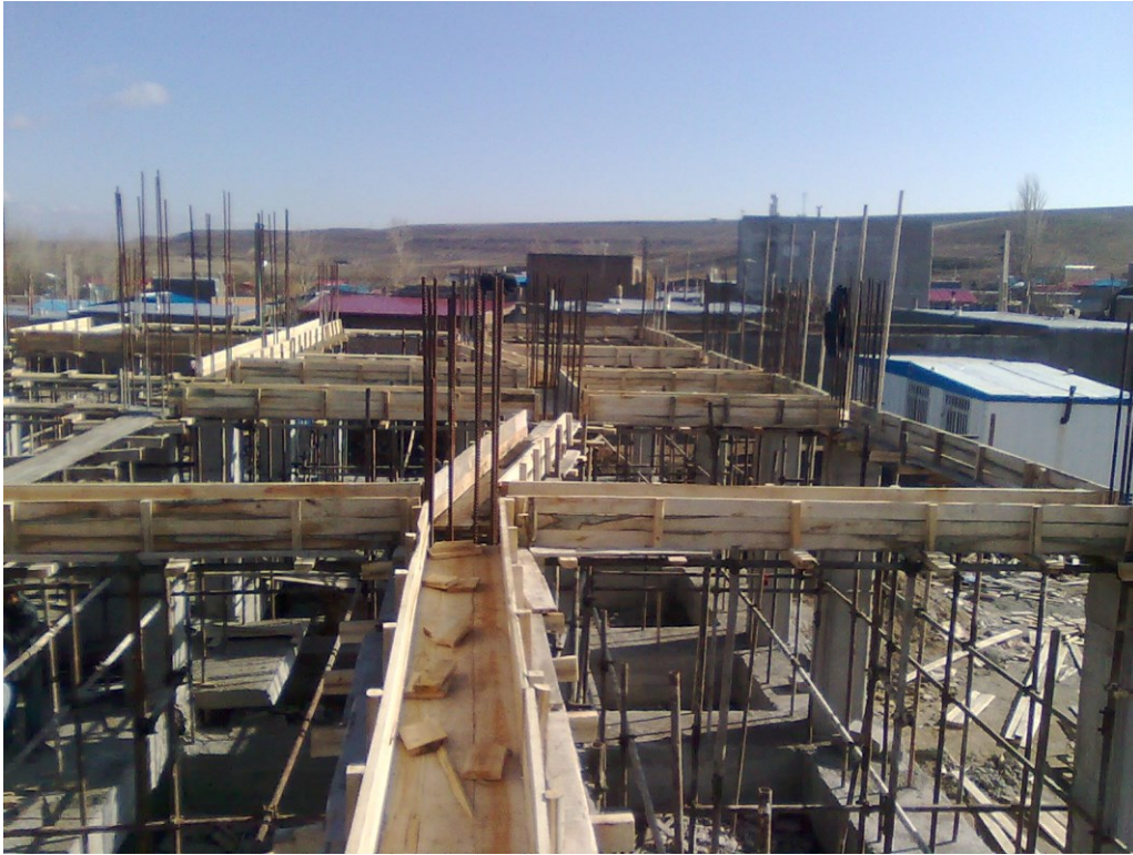
Bild 5: Projekt des IADOEH: Bau einer Grundschule im Erdbebengebiet Azarbaijan
